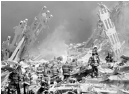
Les décombres. Les attentats terroristes du 11 septembre 2001 contre le World Trade Center de New York ont fait des milliers de victimes. PHOTO KEYSTONE
